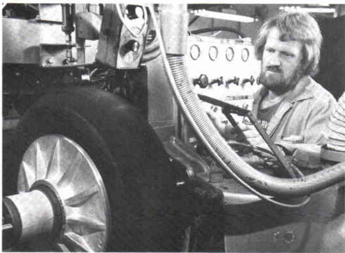
Efter okulärbesiktning kratsas slitbanan ned så att ett 2 mm skikt kvarstår
